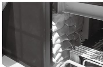
「S118」によるステージ面の振動を抑えるため土嚢を積んで処理(写真は下手サブウーファー)
