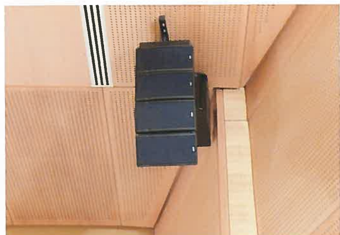
Le système 4 GEO M620 + 1 LS600 par côté. L'amphithéâtre Michel-Ange peut en effet accueillir des projections vidéo/cinéma ou des concerts si désiré.
