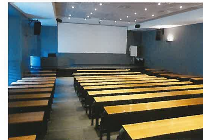
L'amphi Cézanne. Un système de quatre enceintes GEO M620 par côté, complété par une M620 pour les premiers rangs.
