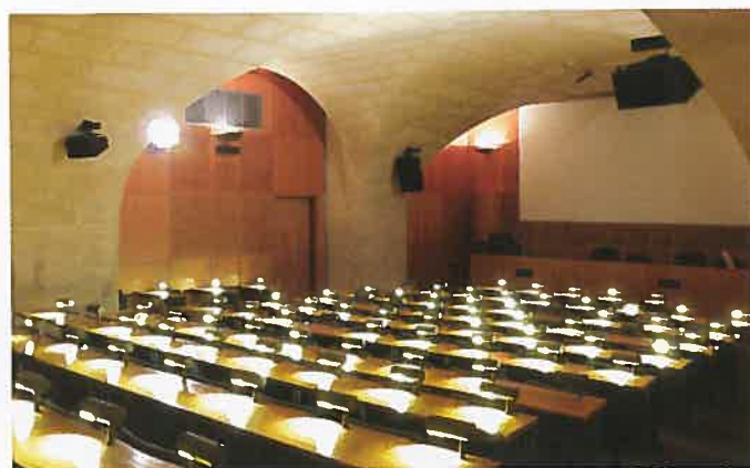
Dans une ambiance de cave voûtée, l'amphithéâtre Dürer utilise un système principal de trois M620, avec un rappel aux deux tiers de la salle. On remarque les deux enceintes de front fill iD24 encastrées dans le meuble/bureau.
