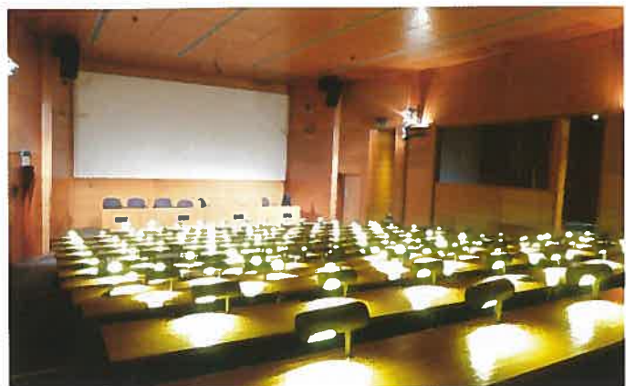
Avec ses cent-quatre-vingt places, l'amphithéâtre Michel-Ange est le plus grand de l'École du Louvre. Sa forme régulière permet de n'utiliser que le système principal, composé de quatre enceintes GEO M620 et d'un caisson LS600 par côté, sur toute la profondeur de la salle. Quatre enceintes iD24 sont dissimulées dans le meuble/bureau, pour les premiers rangs.
