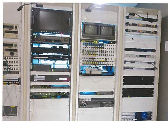
Les racks de la régie de l'amphithéâtre Michel-Ange accueillent aussi le nodal des quatre amphithéâtres. On remarque ici les patches vidéo et RJ45, plus les sources audio/vidéo et, en haut à droite, les récepteurs HF.
