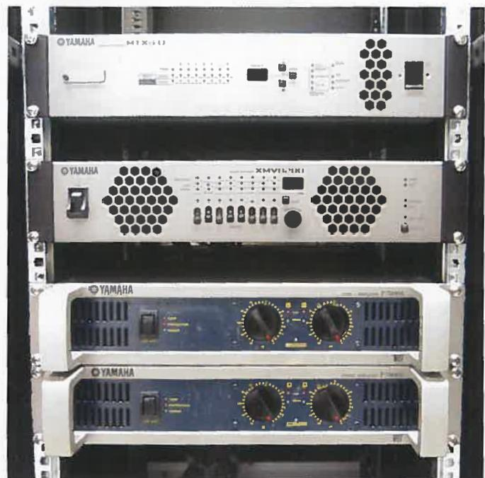
Un des racks d'amplification des quatre nœuds disséminés dans l'Arena du Pays d'Aix. La matrice MTX5D et l'ampli XMV8280 sont standard. Ici, les P7000S alimentent les quatre enceintes CBR15 de la salle d'entraînement.
