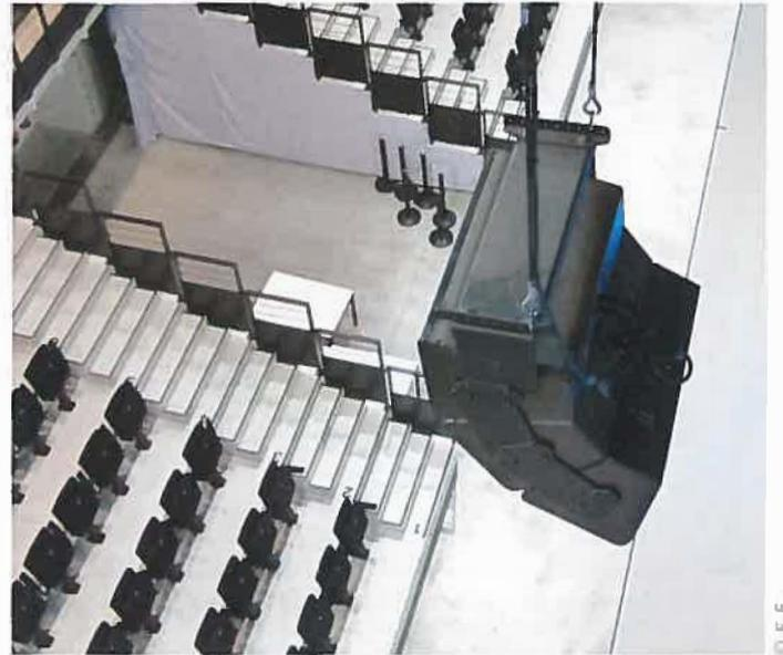
Le cluster de trois enceintes Nexo S12 est suspendu à la verticale de la limite entre gradins et terrain de sport. Le support de montage est spécifique.
